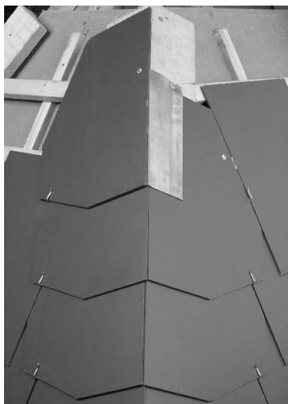
Photo 3: Arêtier avec des ardoises taillées en biais
