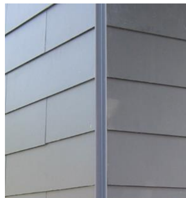
Photo 14: Exemple d'une finition d'angle extérieur
