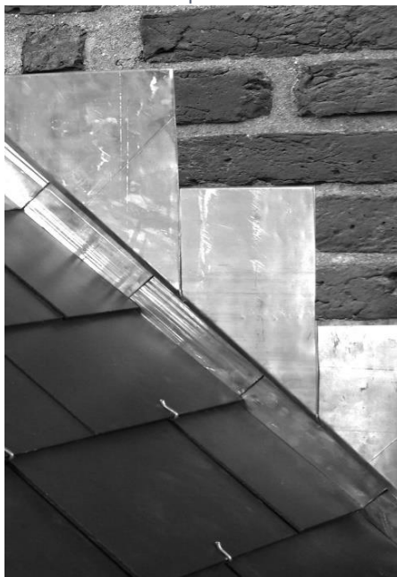
Photo 12 : Raccord de mur
